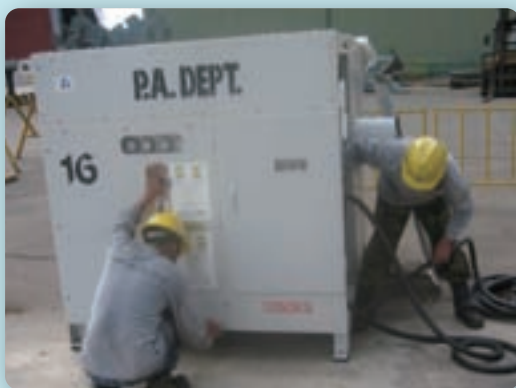
設置作業の様子
